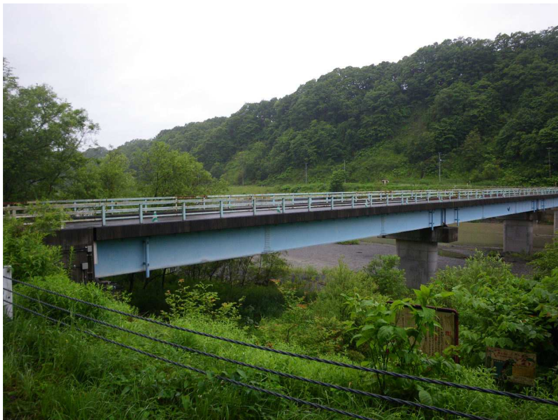
幌毛志橋 橋長:122m 竣工年:平成1年
