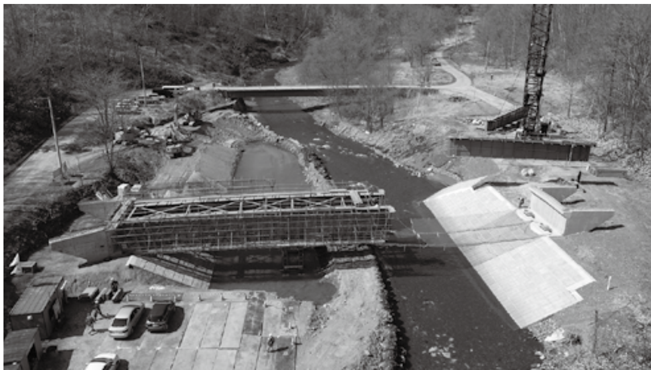
現在の仁世宇1号橋（奥）の下流で新たな架替工事が行なわれている。
