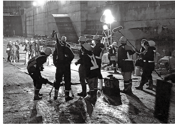
平取ダム建設現場
