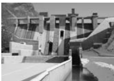
平取ダム堤体
