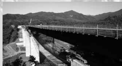
着々と進む芽生貫気別線の橋梁工事
