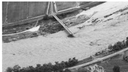
流出した糠平川のアブシ橋 H15 洪水
