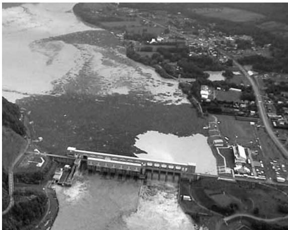
約 5 万 m 3 の流木を捕捉した二風谷ダム
