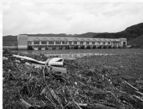
約 5 万㎡、50 年分の流木を捕捉した 二風谷ダム（平成 15 年 8 月）
