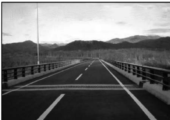
すでに完成した付替え道道芽生貫気別線（宿主別橋）
