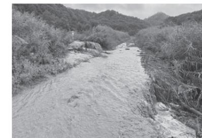
増水した沢水で町道が冠水し、増水した路肩が崩落 (小平別線 池川地先)
