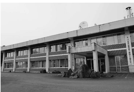
現庁舎（昭和40年完成）
