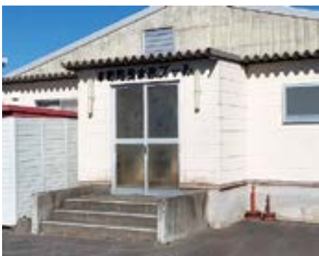
△本町町民水泳プール
