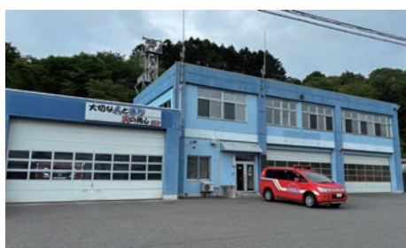
△消防庁舎（昭和49年新築）
