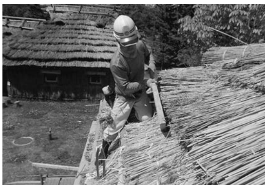
△チセ修復作業の様子
