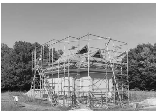
△建設中の慰霊施設の様子
