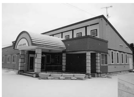
△荷負本村生活館▷
