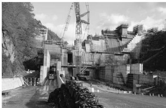
△建設中の平取ダム
